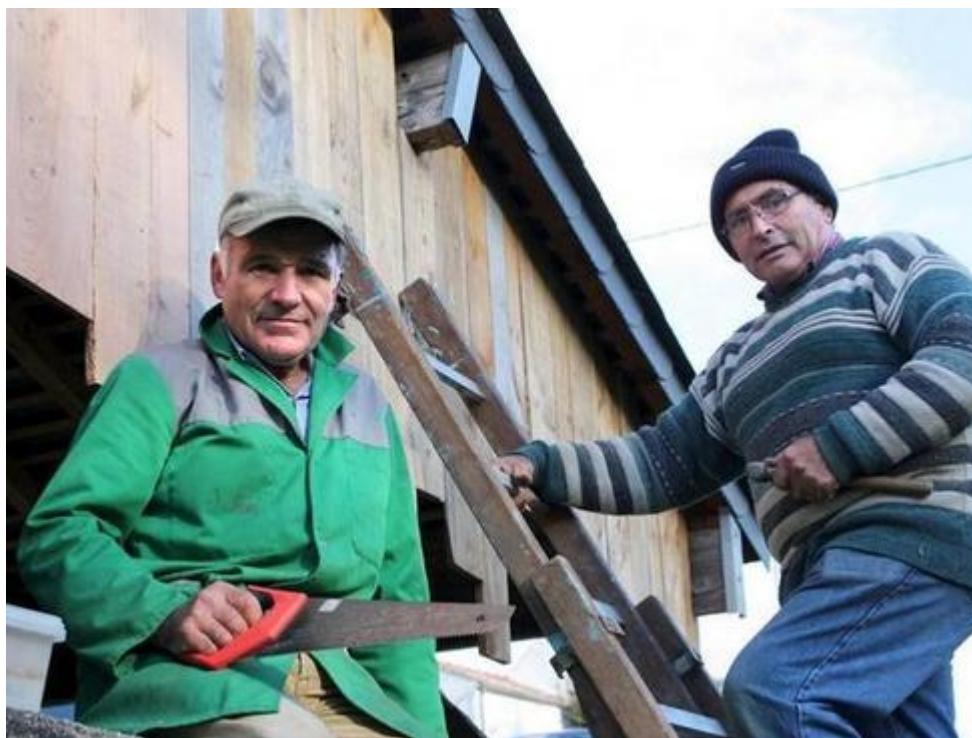
Bernard Bardet et Jean-Claude Fournieux terminent le bardage du lavoir.
